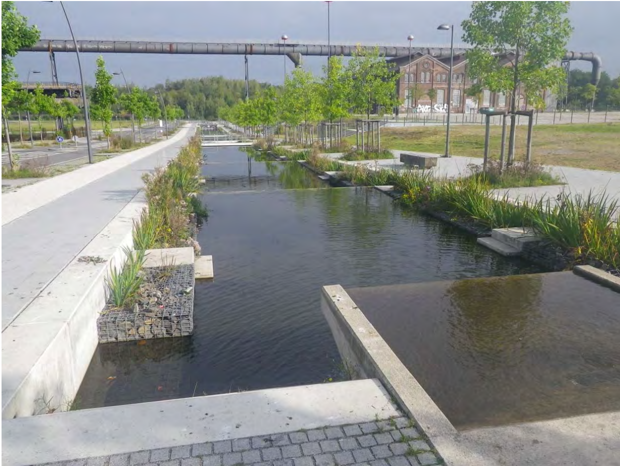
Abbildung 18: Oberflächige Niederschlagswasserableitung im Erschließungsgebiet PHOENIX-West in Dortmund
